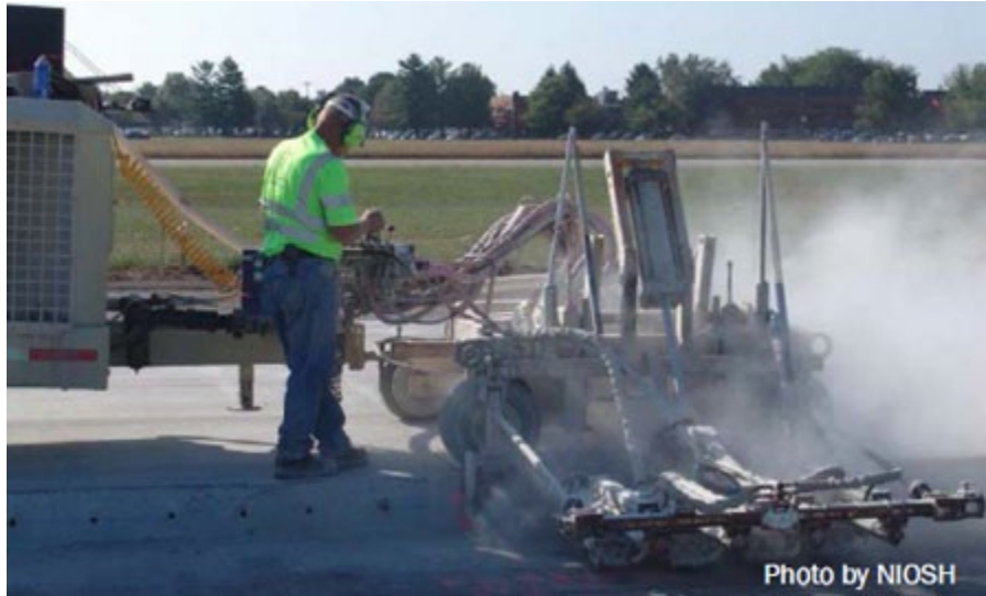
Figura 1. Trabajador operando una máquina de cuatro taladros para colocar pasadores, de deslizamiento sobre losa, sin controles de polvo.
