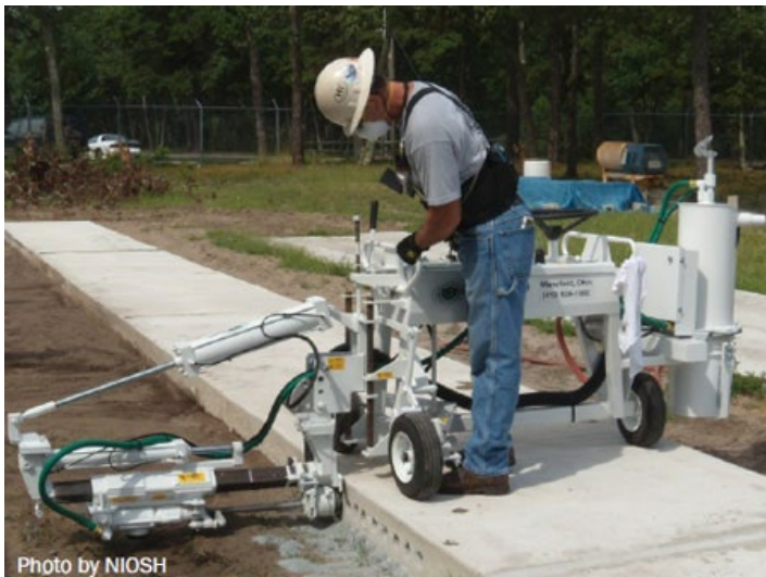
Figura 2. Capacitador operando una máquina de taladro simple para colocar pasadores, de deslizamiento sobre losa, con sistema de ventilación por extracción de aire localizada, en el centro de capacitación.
