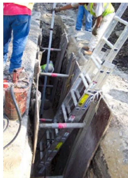
Figura 1. Cuadrilla de trabajadores instalando tubería de agua. Se utiliza apuntalamiento hidráulico de aluminio como sistema de protección en la zanja. [Foto cortesía de George Kennedy, NUCA]
