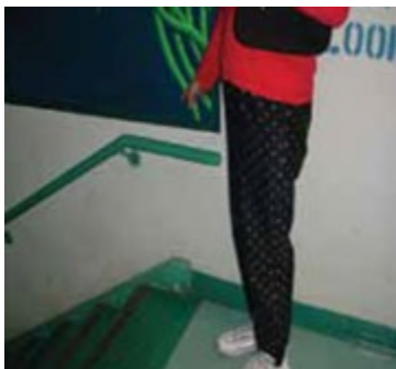
Figura 7.1 El pasamanos se bajó para colocar una pintura grande encima y quedó muy bajo para poder ser usado.
