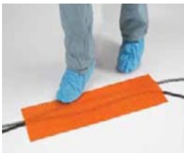
Figura 9.10b Cables en el piso parcialmente asegurados con cubierta para cables. La cubierta se puede extender a lo largo de los cables expuestos.
