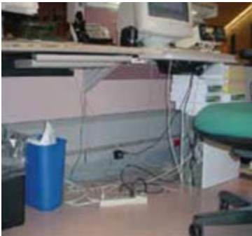
Figura 9.6 Cables sueltos en la estación de enfermería.
