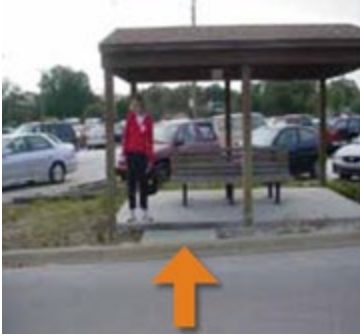
Figura 7.2 Escalones irregulares en la parada del autobús, en donde no hay pasamanos.
