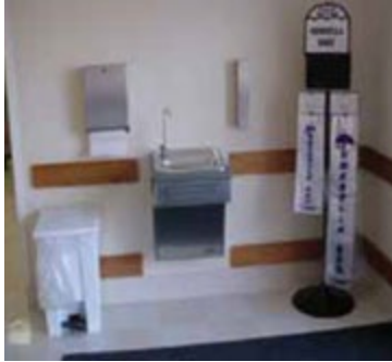
Figura 1.6 Configuración adecuada cerca de una entrada: tapete absorbente grande, bolsas para las sombrillas, dispensadores de toallas de papel y bote de basura.
