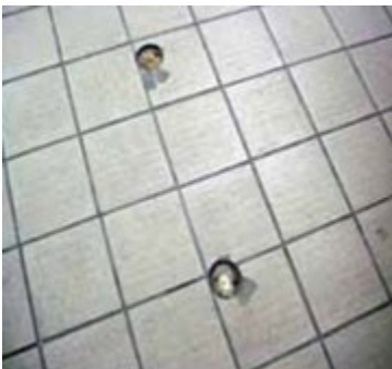
Figura 3.3 Pisos de baldosas con huecos que no se parcharon después de que algo se removió.
