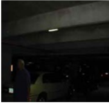
Figura 6.1 Área de estacionamiento con poca luz; lámpara parcialmente bloqueada por vigas del techo.
