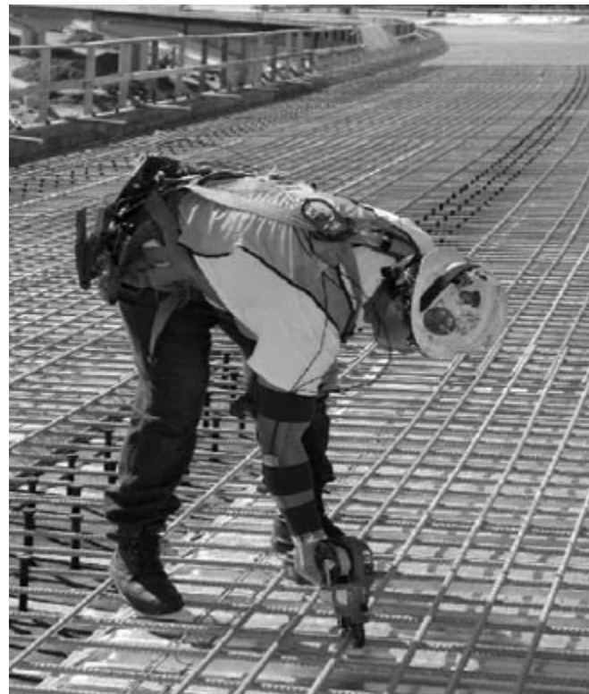
Figura 2 Atado de barras de armadura para concreto mediante el uso de herramienta motorizada MAX-USA RB-392. Obsérvese la postura encorvada.
