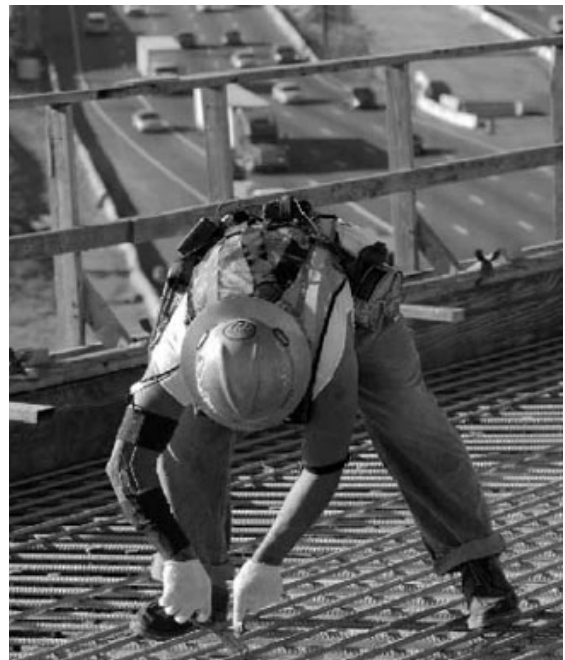
Figura 1 Atado de barras de armadura para concreto mediante el uso de tenazas. Obsérvese la postura encorvada y la posición incómoda de la mano.
