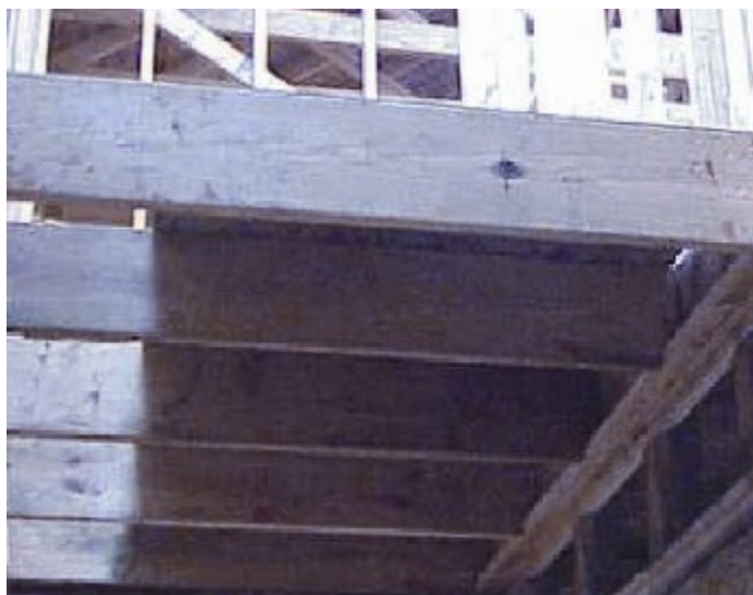
Figura 2 Vigas de pisos tradicionales.
