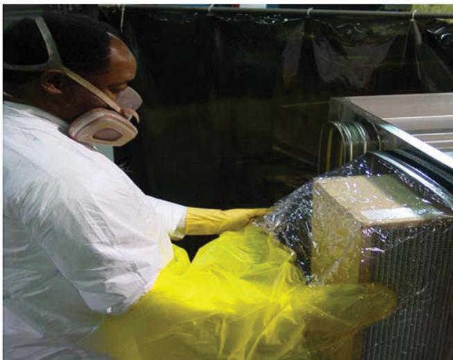
Figure 19. Retrait d'un appareil de ventilation d'un filtre à air sale ensuite déposé dans un sac plastique pour minimiser l'exposition de l'employé aux particules saisies par l'unité de filtration (utilisé avec l'autorisation de Filtration Group Inc. [2012])
